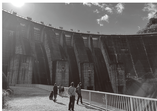
▲高山ダム堤内探検ツアー
