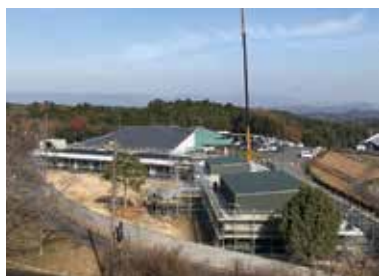
こども園建設現場
