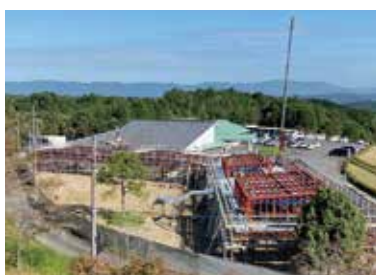
こども園建設現場
