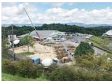
こども園建設現場
