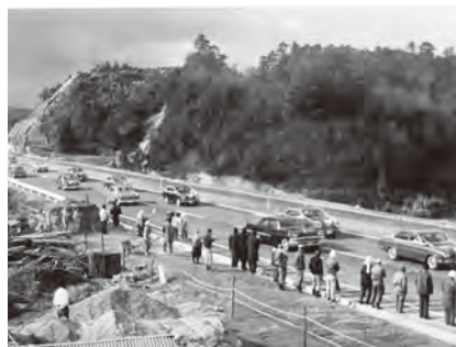
2車線が開通したころ
