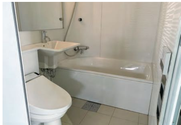
かんせい 完成したユニットバス じつ けんせつげんば (実さいは建設現場で組み立てる)
