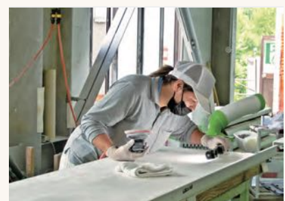
天板の点検、補修
