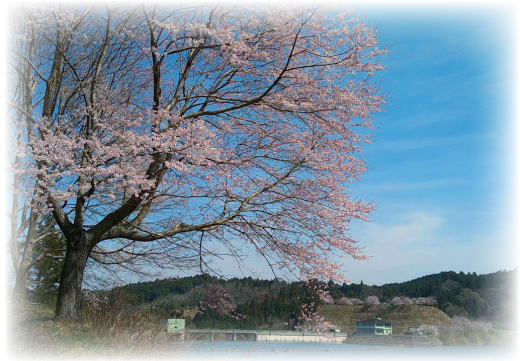
②上津ダム
