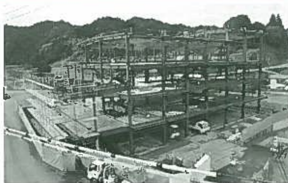
11月10日時点の様子 （鉄骨建設工事が完了し、足場を組立てています）
