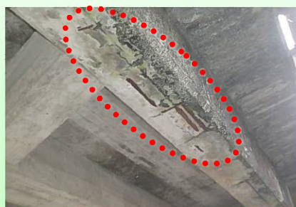
主桁の損傷（鉄筋露出）
