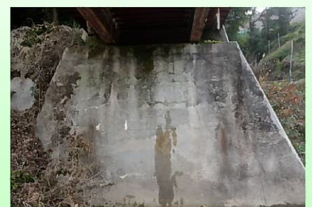
橋台の損傷（ひびわれ）
